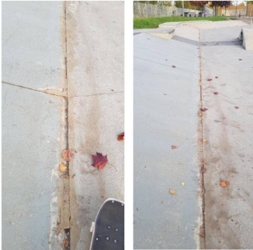
Ca. 38 Meter der Fugen sind beschädigt und müssen dringend erneuert werden. Die Beschädigungen können zu einem Sicherheitsrisiko werden, da sich die Rollen in den Fugen verfangen. Regenwasser sammelt sich in den Fugen was zur weiteren Beschädigung führt, besonders bei Bodenfrost. Eine Instandsetzung der Fugen ist unumgänglich!
