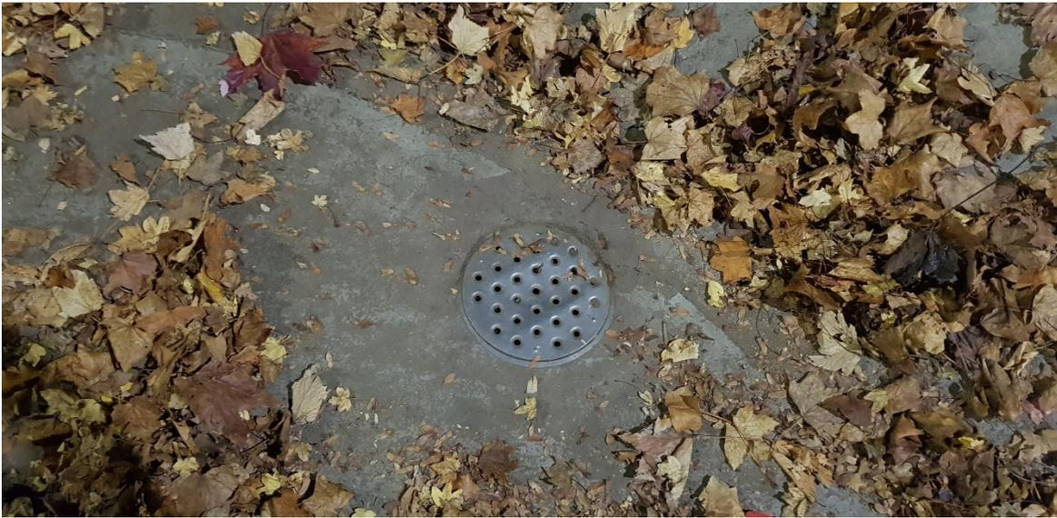
Beschädigung: Fangkorb verstopft, Drainage ohne Funktion. Das stehende Regenwasser führt dazu das der Beton leidet und den Zustand des Elements zunehmend verschlechtert. Zudem sollten die Fugen im Bowl erneuert werden. Die Oberfläche ist ebenfalls wieder sehr rau, der Bowl könnte erneut mit Spezialfarbe gestrichen werden. Ggf. sollten die Oberfläche vorher geglättet werden.
