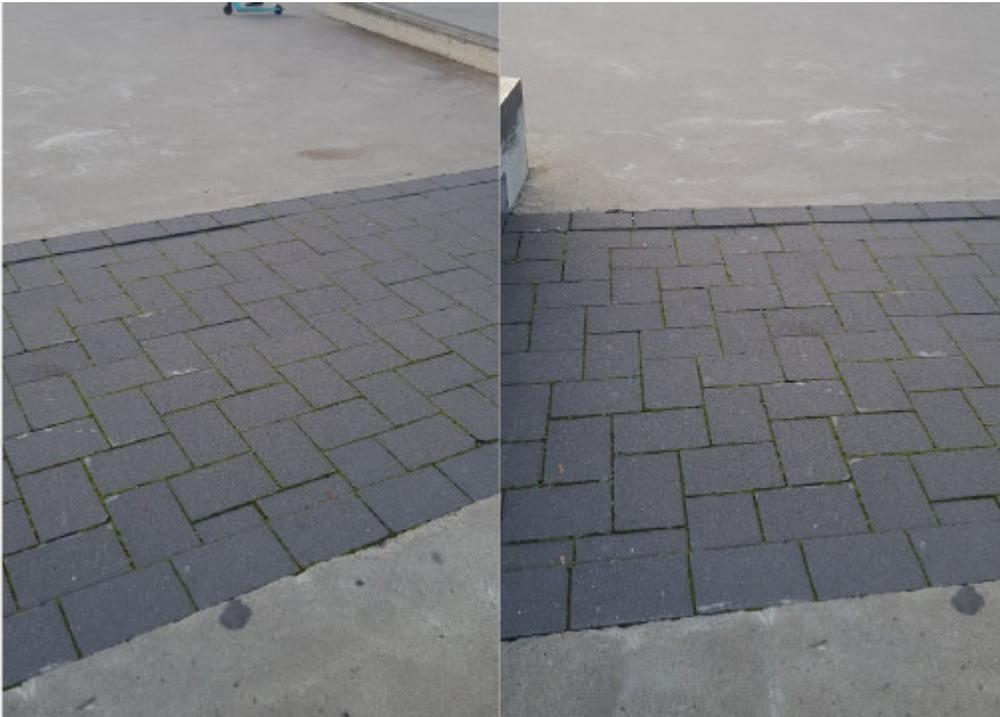
Beschädigung: Absacken von Pflastersteinen. Die Pflastersteine der Drainage sind abgesackt und bilden Fugen. Die Beschädigungen können zu einem Sicherheitsrisiko werden, siehe oben.
