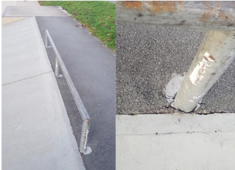
Beschädigung: Schäden an Verankerung im Asphalt. Das Flatrail-Element auf der großen Bank ist nicht mehr fest im Asphalt verankert. Die Verankerung hat Spiel und wackelt. Ohne eine Instandsetzung wird die seitliche mechanische Belastung dazu führen das die Verankerung sich weiter löst.
